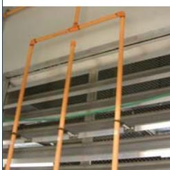
O fumo em compartimentos com ar condicionado, levado pelo fluxo do ar, move-se em direcção à ventilação de retorno e não em direcção ao tecto. A instalação de uma tubagem de recolha de ar ao longo da ventilação, permite a detecção precoce do fumo.
