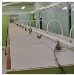
Tubos capilares derivando da tubagem principal para dentro de armários de equipamento, permitem um aviso ultra precoce de presença de fumo nesses espaços interiores.
