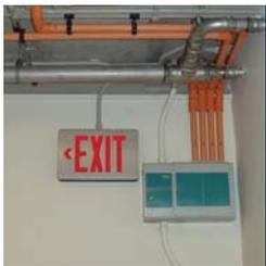
Em pequenas instalações, pode ser utilizado um detector VESDA para proteger várias áreas como, por exemplo, tecto, ventilador e zonas inferiores ao nível do chão.
